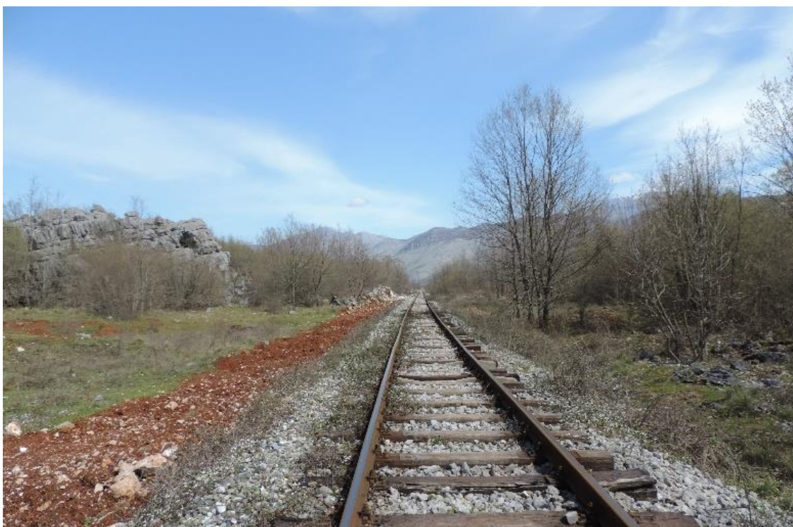
Figure 6.35_Foto nga kalesa në nivel Skac (km 133+370) deri në ate ne Popaj (km 135+210); Pamje J-V; Majtas: bimësia e pastruar për instalimin e tubacionit të ujit; hekurudha kalon nëpër shkurre, parcela me kullota dhe pemë të rralla. Shkurret perfaqesohen kryesisht nga shkoza. Pemët lloje dushku. Traseja është shumë e ulët; hekurudha ndodhet 1.0 km nga kufiri lindor i RMN dhe 2.1 km nga bregu i liqenit; një terren kodrinor ndan linjën hekurudhore nga bregu i liqenit
