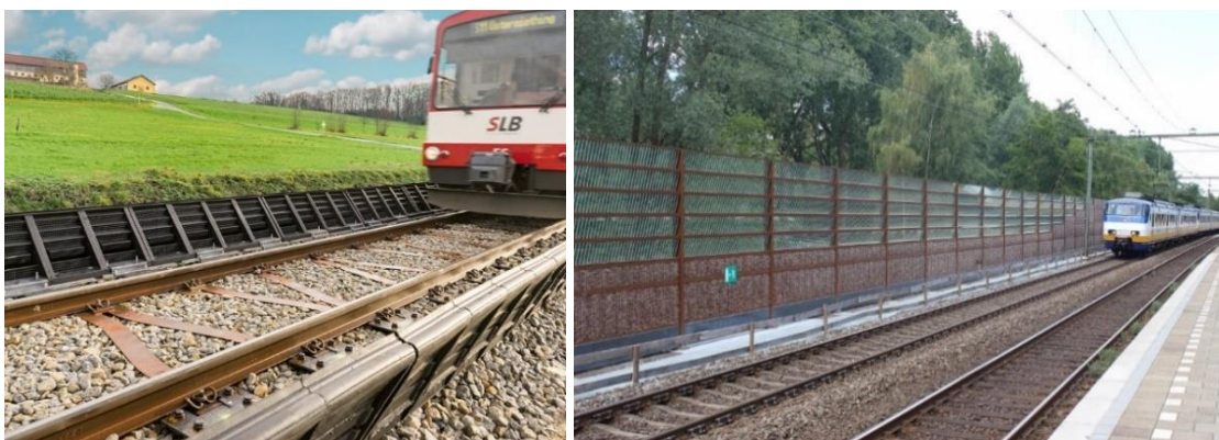
Figura 6-13_Majtas: Barriera e ulët dhe absorbuese e zhurmës; Djathtas: Lloji i përzier i barrierave të zhurmës 224
