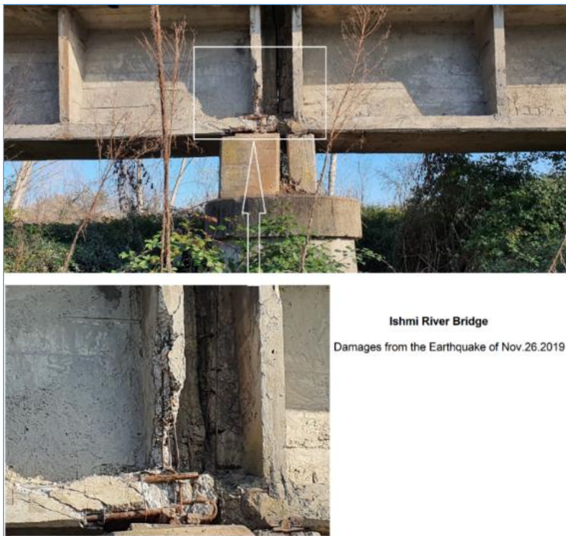
Figure 5-24_ Ura e Ishmit e demtuar nga termeti 1 26 nentorit 2019
