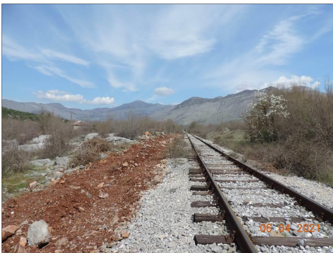
Figure 6.17_Bimesi e pastruar ne brezin e punimeve, ne te majte te hekurudhes (km 132+600 deri ne km 135+200)
