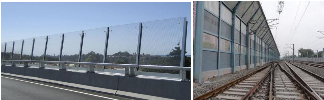
Figura 6-10_ Shembull i barrierës së pjerrët të zhurmës 220
