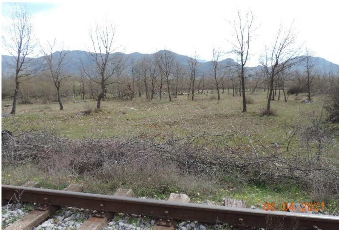
Figure 6.32_Pamje P-L. Kalesa ne nivel, Skac; Nga km 132+620 ne km 133+370; Permes nenzones se perdorimit tradicional. Hekurudha kalon 900m ne perendim te kufirit lindor te RMN dhe 2.15 km nga bregu i liqenit te Shkodres. Nje terren kodrinor ndan hekurudhen nga liqeni. Bimesia ne foto perfaqesohet nga kullota dhe pyll i demtuar lisi
