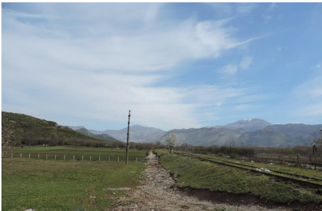
Figure 6.29_Pamje J-V. Kalesa ne nivel, Bajze; Nga km 132+280 ne km 132+620; Toka bujqesore permes nenzones se perdorimit tradicional, ne ted y anet e hekurudhes; Km 132+280; Hekurudha kalon 1.0 km ne perendim te kufirit lindor te RMN dhe 2.5 km nga bregu i liqenit te Shkodres. Nje terren kodrinor ndan hekurudhen nga liqeni.
