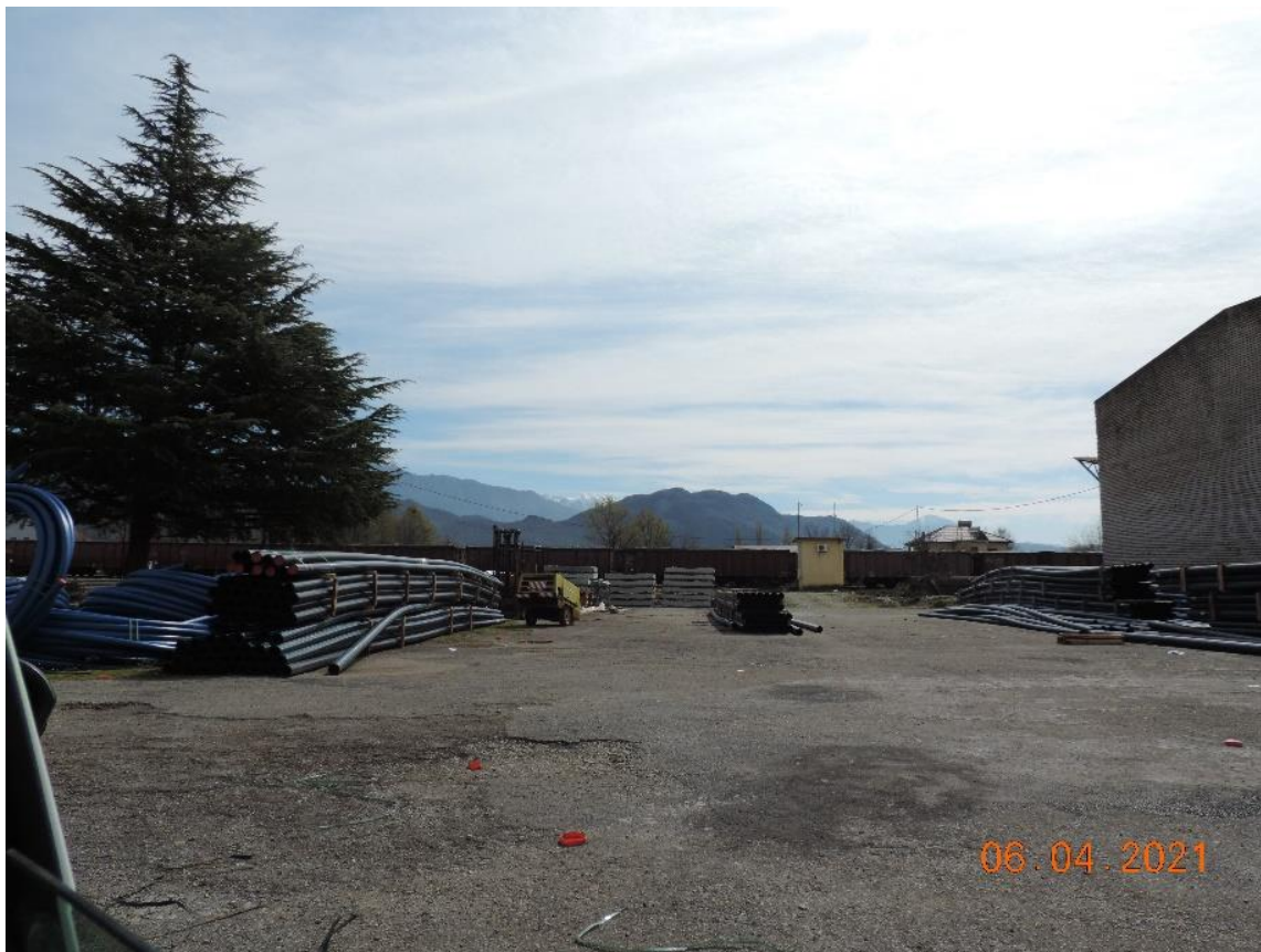
Figure 6.14_ Siperfaqe e asfaltuar ne stacionin e Bajzes
